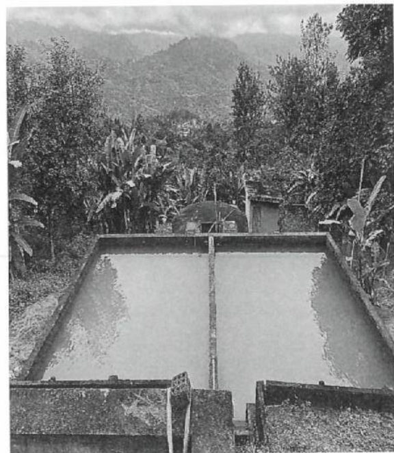
CASETA Y FILTROS
