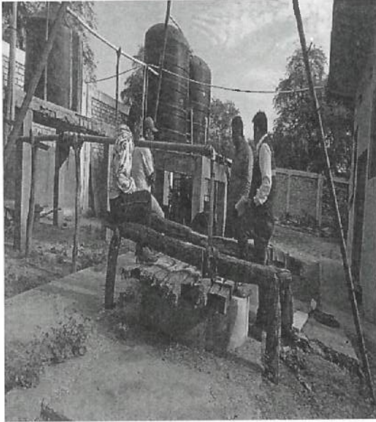
CASETA Y CERCO PERIMETRICO
